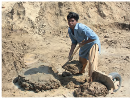
Die Vorbereitung des Lehms ist Schwerarbeit...
